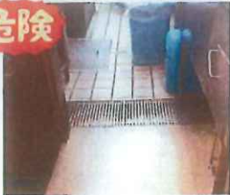
洗剤ラインシンクの前の通路
