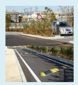
構内における制限速度 表示や速度抑制用の 減速帯の設置
