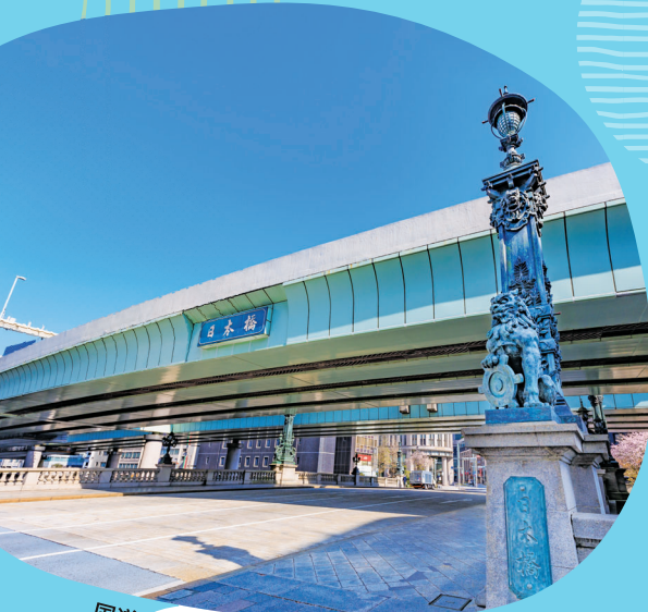
国道の起点「日本橋」
