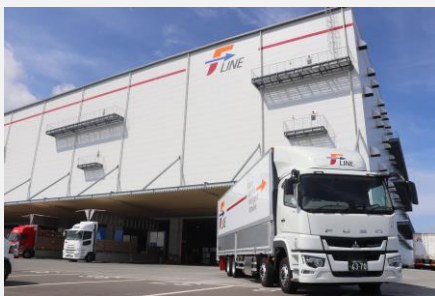
※上記写真は福岡第一物流センター（福岡県福岡市）
