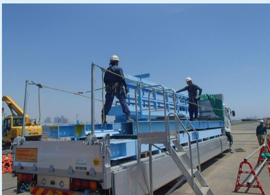
【荷台に取り付けた支柱を利用した親網の設置、昇降設備の導入】 ◎ 荷役作業中の墜落防止対策に効果あり ◎ 荷台への飛び乗り・飛び降りを防止できる
