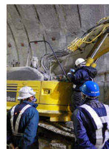
(3) 車両系機械を用いた測定
