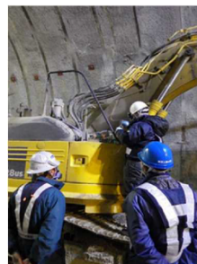
(3) 車両系機械を用いた測定
