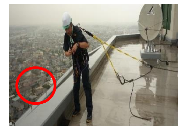
墜落防止措置が取られた事例
