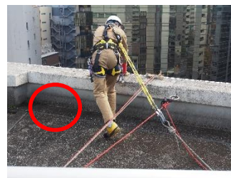
墜落防止措置が取られた事例
