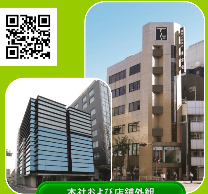
本社および店舗外観
