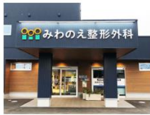
内外装の施工
