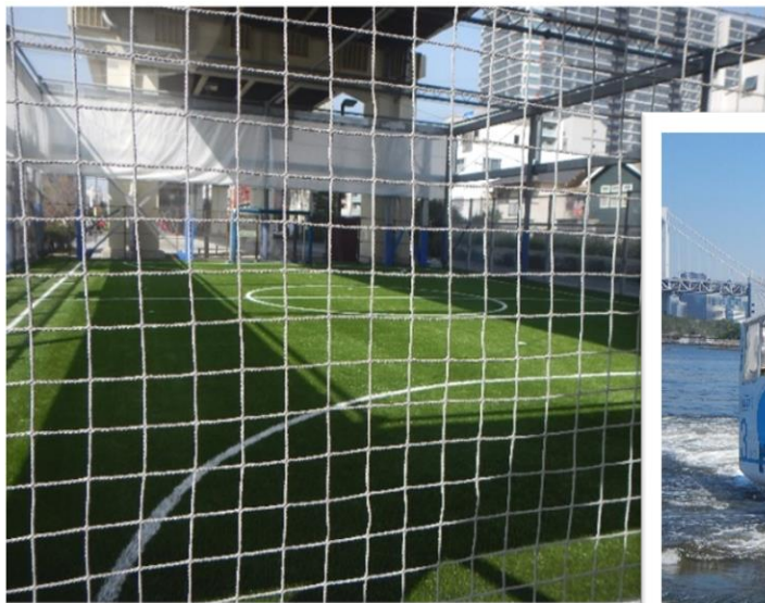
フットサル場の防音工事
