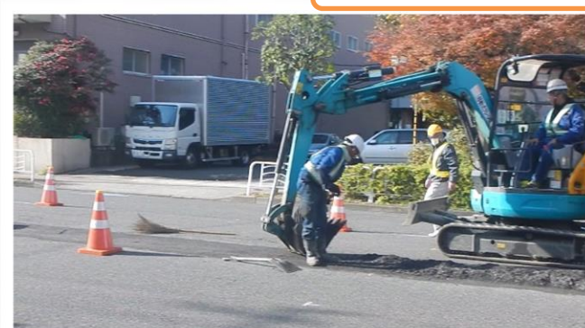
地元の道路舗装工事
