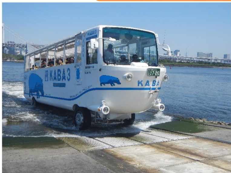
お台場の水陸両用バスのスロープにすべり止めを設置した工事
