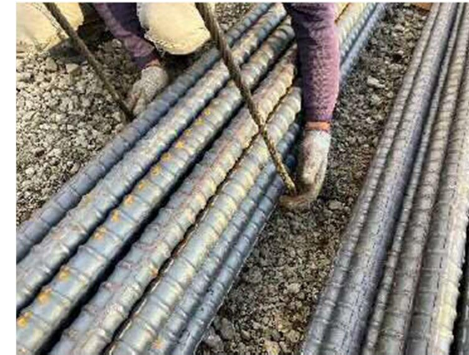
被災状況の再現写真
